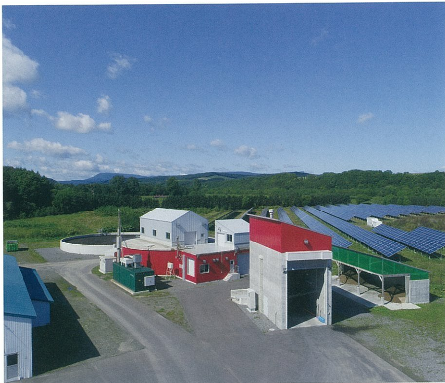
図3 町営の奥部北興バイオガスプラント(写真:北海道奥部町より提供)
